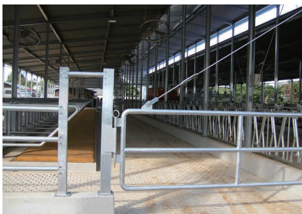
牛が自由に動き回れるスペースを持つ「フリーストール」型の牛舎の施工例
